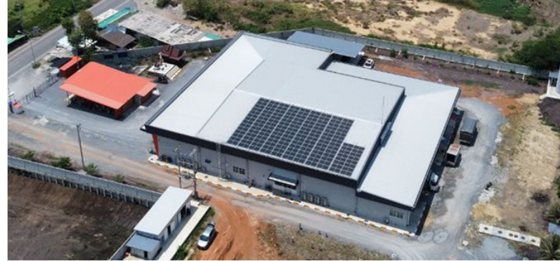
สมจิตฟาร์ม ( บริษัท สมจิตฟาร์ม 2000 จำกัด) จังหวัดนครปฐม Capacity : 60 kWp Solar Rooftop
