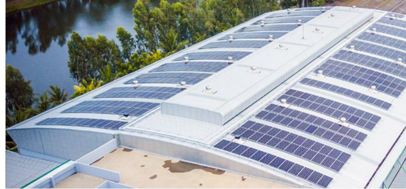
วิ.พี.เอส. ฮีลวิเบเนท์ จำกัด จังหวัดปทุมธานี Capacity : 300 kWp Solar Rooftop
