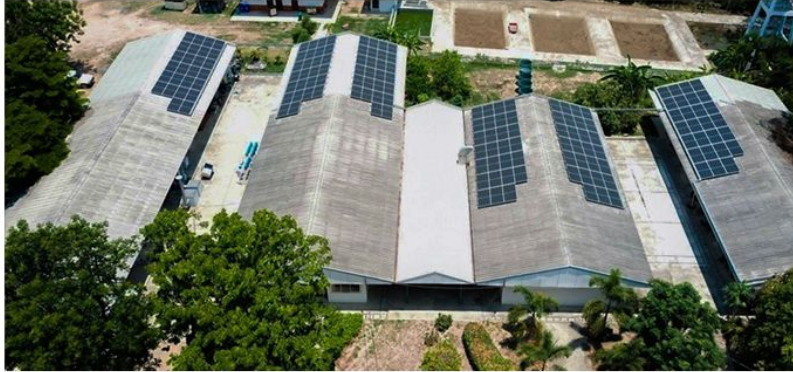
โรงพยาบาลดลสินพรเกียรติ นครราชสีมา Capacity : 60 kWp Solar Rooftop
