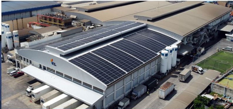
บริษัท โอทีเอสพลัส จำกัด | ไทศรี บริษัท ไทยยูเนี่ยน กรุ๊ป จำกัด (มหาชน) จังหวัดสมุทรสาคร Capacity : 514.08 kWp Solar Rooftop
