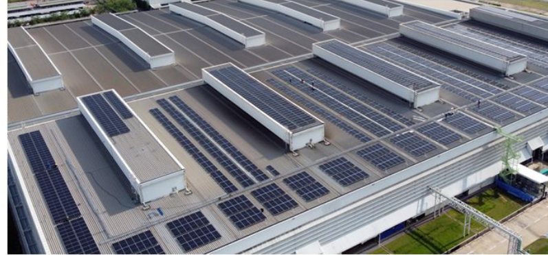
บริษัท โอโซน ไทย ออโตโมทีฟ คาสติง จำกัด จังหวัดปราจีนบุรี Capacity : 999 kWp Solar Rooftop
