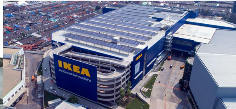
อิกีย บางใหญ่ จังหวัดนนทบุรี Capacity : 1.45 MWp Solar Rooftop
