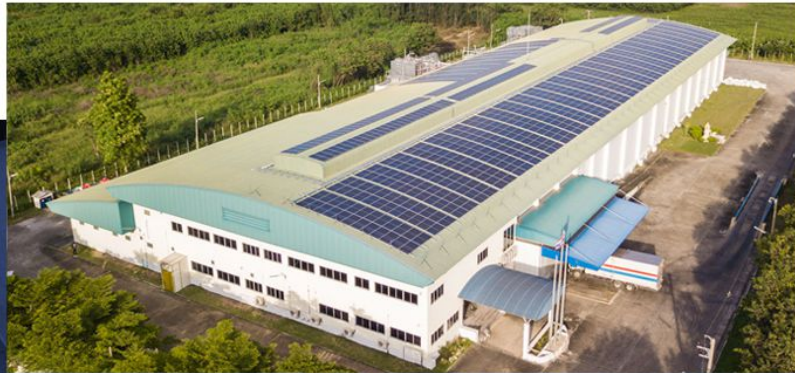
บริษัท เมลลิสรีฟรอมพ์ตัน จำกัด จังหวัดลพบุรี Capacity : 487 kWp Solar Rooftop
