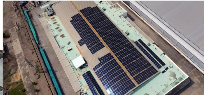
บริษัท ไทยอเนก จำกัด บริษัทอุตสาหกรรมเบียร์ จังหวัดปทุมธานี Capacity : 492.48 kWp Solar Rooftop
