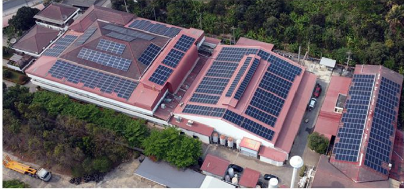
บริษัท อามอนี อีเลคทรอนิกส์ (ประเทศไทย) จำกัด จังหวัดราชบุรี Capacity : 400 kWp Solar Rooftop
