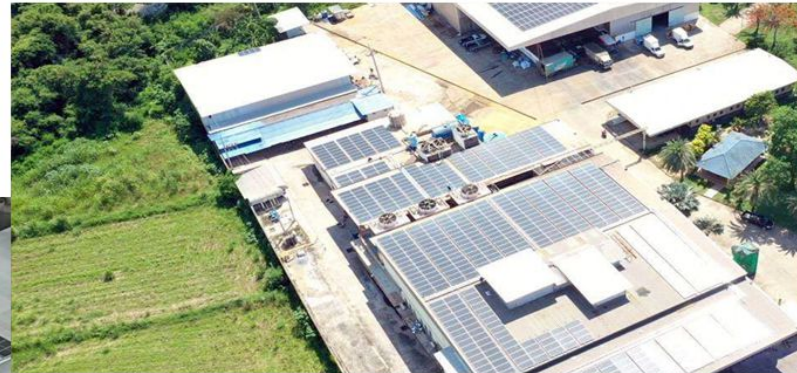
บริษัท เอสเค อินเตอร์พรีต จำกัด จังหวัดตาก Capacity : 670 kWp Solar Rooftop
