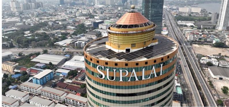
บริษัท ศุภาลัย จำกัด (มหาชน) อาคารศุภาลัย แกรนด์ ทาวเวอร์ สำนักงานใหญ่ พระราม3 Capacity : 421.08 kWp Solar Rooftop
